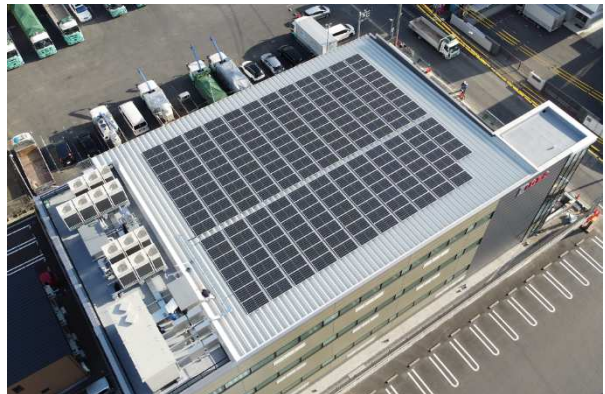
屋上に設置した太陽光発電パネル
